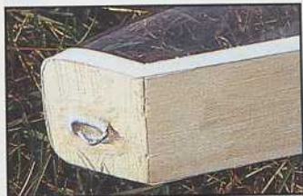
Le crochet sert à fixer la verrière.
